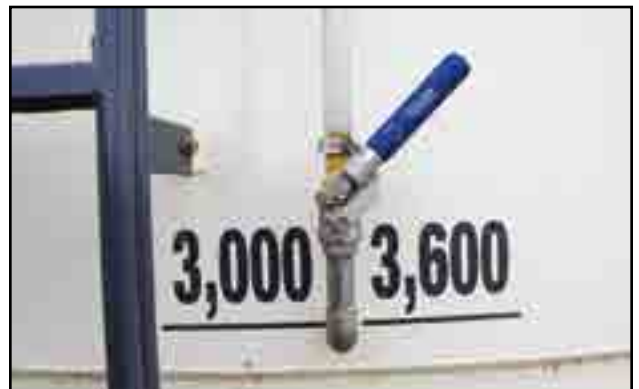
Fig 30 - Vanne à liquide
