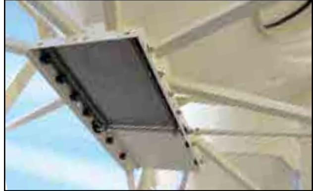
Fig 4 - Porte coulissante fixée sous la goulotte de déchargement
